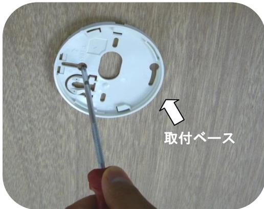
取付ベースを天井の補強材が通っている場所や壁の柱に、付属のネジ2本でしっかり取り付けます。
