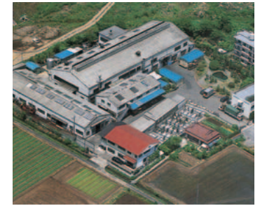
埼玉工場全景
